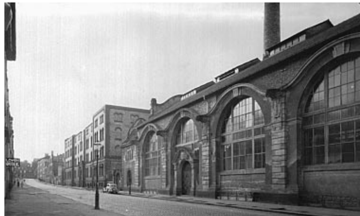
Die Versuchsanstalt für Straßenwesen wurde 1926 als Straßenbau-Institut gegründet. Das Institut befand sich im Erdgeschoss und in den Kellerräumen eines ehemaligen Kasernengebäudes in der Magdalenenstraße. Heute sind dort in den „neuen“, 1957 bis 1959 erbauten Gebäuden Bereiche des Maschinenbaus untergebracht.
